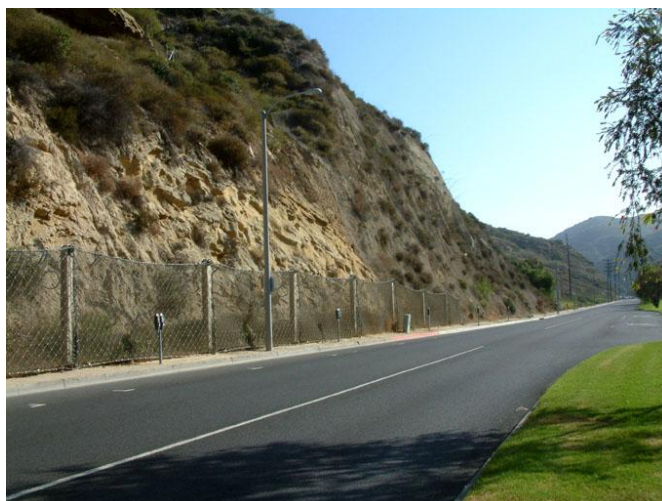
Εικόνα 18.6: Δίκτυ Συγκράτησης Κατολισθήσεων σε Πρόποδες Πλαγιάς
